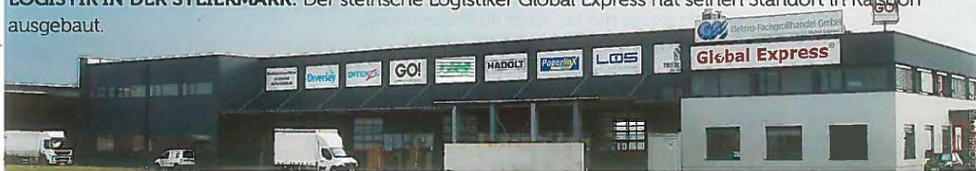
Blick auf die neue Halle von Global Express am Standort Kalsdorf bei Graz
